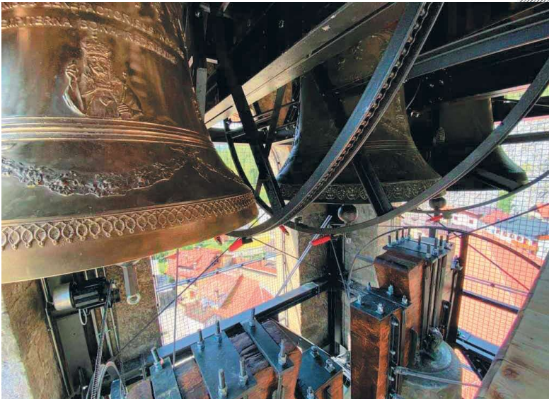
Il progetto del castello costruito in laboratorio e installato nella cella campanaria - il sollevamento e il posizionamento delle sette campane del nuovo concerto
